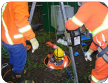
工人進入沙井
