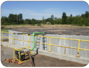
Bể chứa nước nâu
