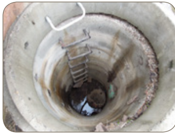
Miệng hầm xuống đường ống thoát nước mưa
