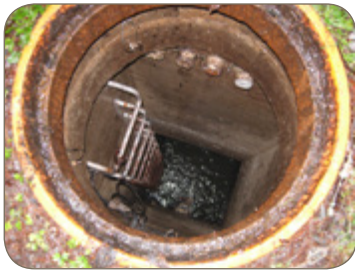
Miệng hầm xuống đường ống cống
