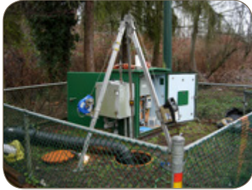
출입 및 환기 장비 설치
