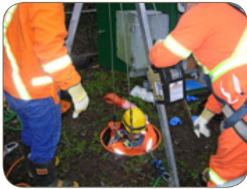
Trabajador ingresando por una boca de alcantarilla
