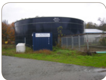
Tanque de estiércol a ras de tierra
