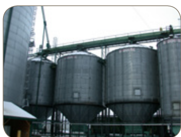
Silos de almacenamiento
