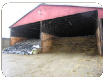
Búnker de almacenamiento a ras de tierra
