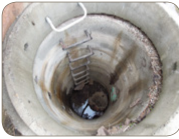
Entrada de alcantarilla de aguas pluviales
