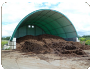
Búnker de almacenamiento de compost
