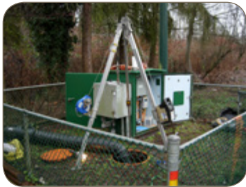
Entrada y montaje de equipo de ventilación
