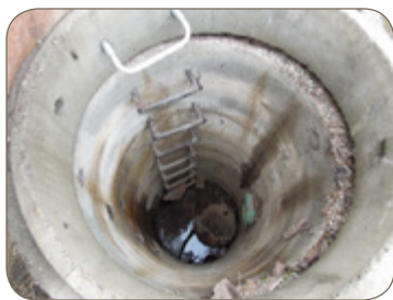
Entrada de alcantarilla de aguas pluviales
