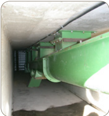
Transportador en un túnel
