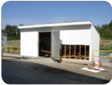
Cobertizo de bombeo
